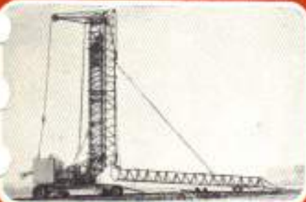
Grue pré-câblée : pas de mât rallonge
